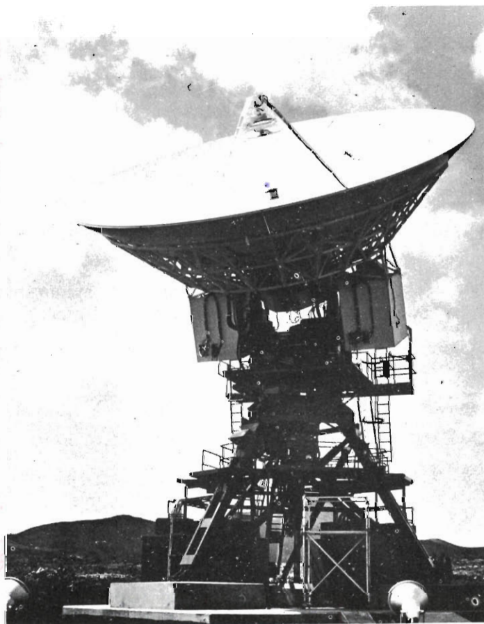
Aereo a disco da 13 m installato nell'isola Ascensione, presso la stazione a terra costruita per conto della Cable and Wireless dalla Compagnia Marconi.
